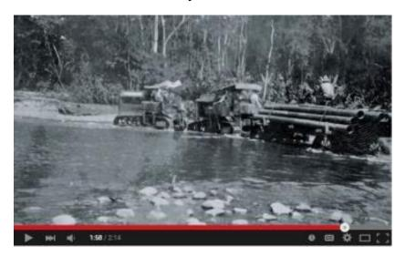
[une photo de deux bouteurs se déplaçant en bordure d'une rivière et tirant une pile de tubage est affichée.]
